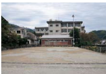
建設予定地 (中山地域事務所跡地)
