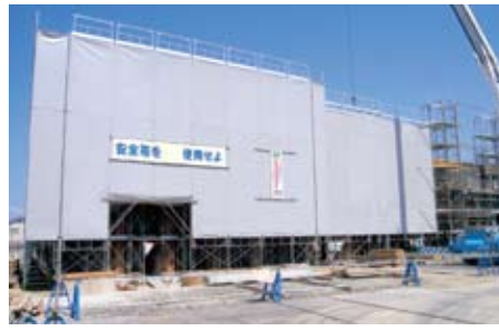
建設中の総合保健福祉センター
