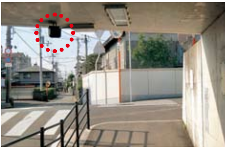
防犯カメラ (郡中小学校通学路)
