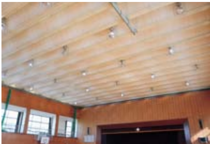
体育館の天井調査
