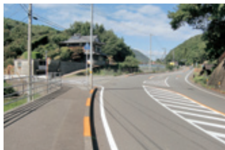
インターチェンジと国道との接続予定箇所
