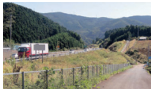
接続予定箇所 (市道から高速本線を望む)
