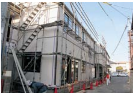
建設中の介護施設 (米湊)
