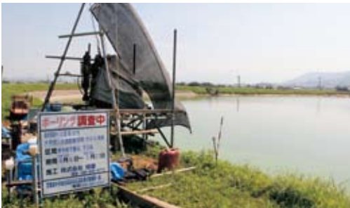
ため池の耐震性点検（岩崎池）
