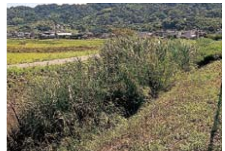
流水に支障を来している河川
