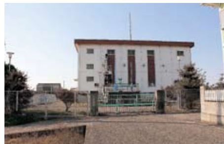
大谷ポンプ場
