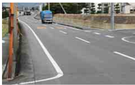
大型車の交通量が多い 「稲荷下三谷線」
