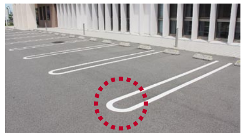
二重線による駐車枠 (市総合保健福祉センター内)
