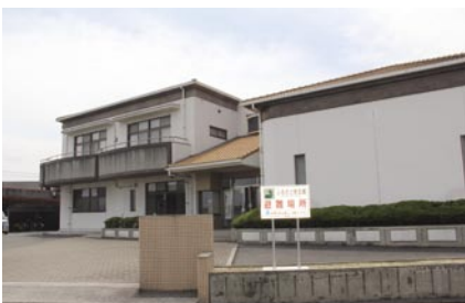
郡中地区公民館 (旧ふるさと創生館)
