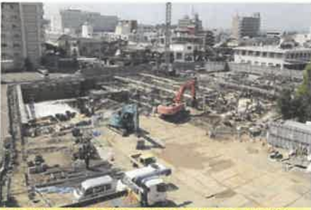
基礎工事の様子(29年9月1日撮影)
