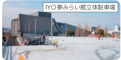
令和2年3月に完成した「IYO夢みらい館」立体駐車場
