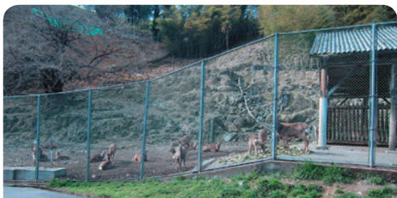
栗の里公園内にある鹿牧場。抜本的な施設改修を行わない限り、今後の施設運営は困難な状況である。
