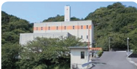
老朽化が進んでいる「伊予地区清掃センター」。更新には多額の費用もかかることから広域化・集約化の実現が期待されている。
