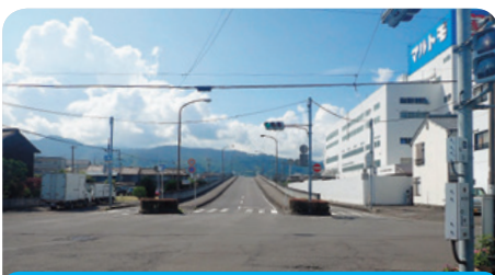
今年度、「打換え工法」により舗装修繕工事を実施する予定の市道の一つ「内港稻荷線」
