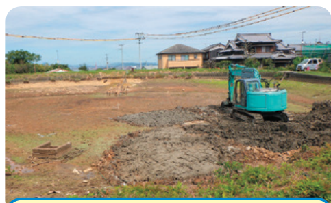
現在改修中の「稲荷土段池」
