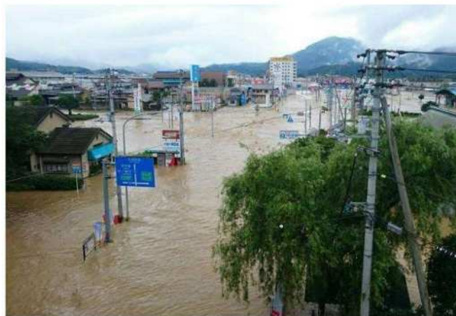
平成 30 年 7 月豪雨による冠水（大洲市）
