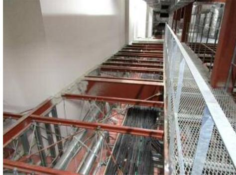
学校給食センターは鉄骨造2階建てで、約15メートルの高さがあります。通常の建物であれば3階建てに近い高さになっていますが、これは、屋根裏に給排気設備・空調設備などの機器やダクト・配線があるためで、2階部分の上半分には大きな空間が広がっています。
