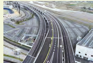
松山外環状道路空港線の側道部
