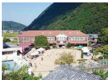
翠小学校の木造校舎
