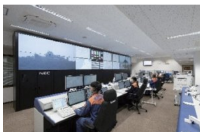
松山圏域消防指令センター
