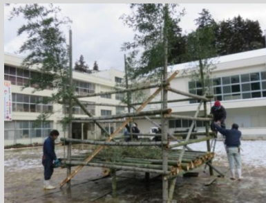
前日からやぐらの組立てを行いました
