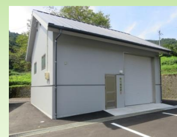
新たに設置された防災備蓄倉庫
