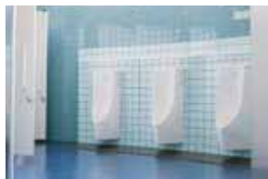
段差が解消された男性用トイレ
