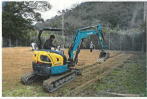
ショベルカーで古い土を除去
