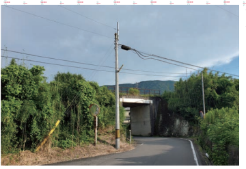
JRTンネルの所にある防犯灯
