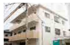
市営下灘団地完成
