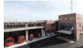
「伊予消防署新庁舎」全景
