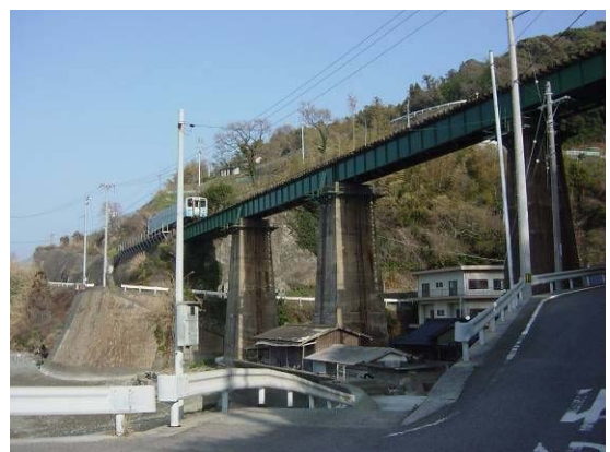
鉄道橋（串地区）
